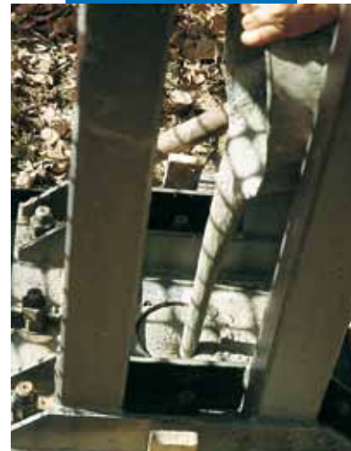
Inghisaggio con Mapefill
